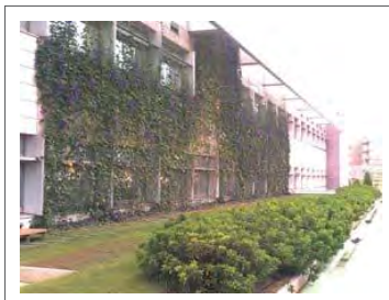
建築物の外壁面の緑化
